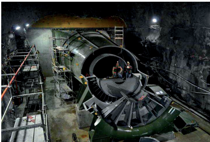
Рисунок 1 - Фото монтажа ПГВУ шестое рудоуправление «Беларусь калий» РУП ПО
