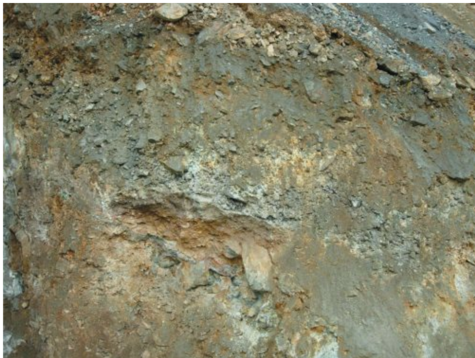
Рис. 3.5.10. Вид горной массы в зоне обрушения камеры 34-013
