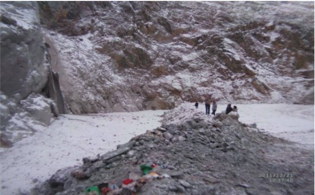
Рис. 3.3.16. Возведение комбинированного искусственного целика вдоль борта карьера (твердеющая закладка + скальная пригрузка)
