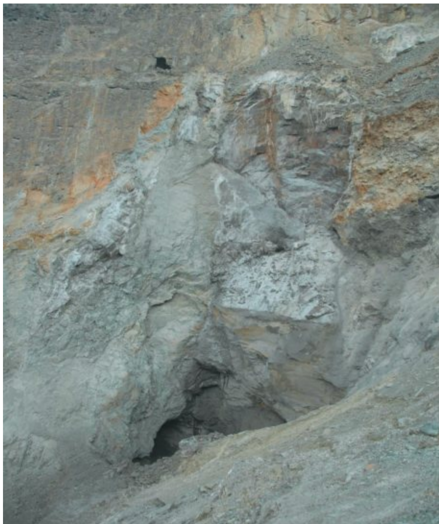
Рис. 3.4.24. Отработка запасов временного рудного целика (камера 34-015) между заложеной камерой и пространством карьера (ЭТАП-2). В центре кадра – закладочный массив ранее отработанной и заложеной камеры 34-014 (этап 1)
