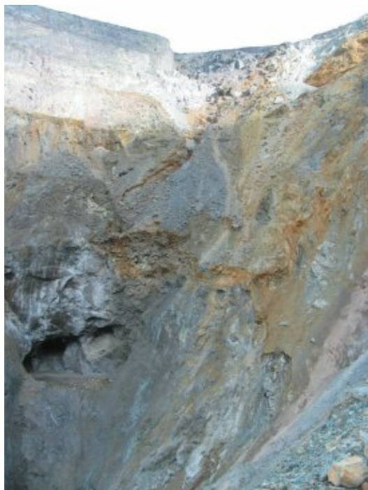
Рис. 3.4.20. Состояние устойчивости уступов, примыкающих к опытному участку после отработки и закладки камеры 34 – 014 (ЭТАП-1)
