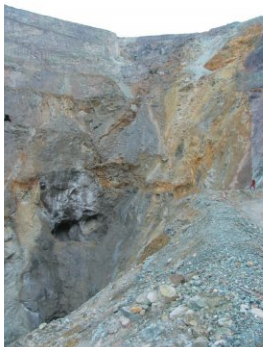
Рис. 3.4.21. Состояние устойчивости борта карьера в целом над обрабатываемым участком после отработки и закладки камеры 34 – 014 (ЭТАП-1)
