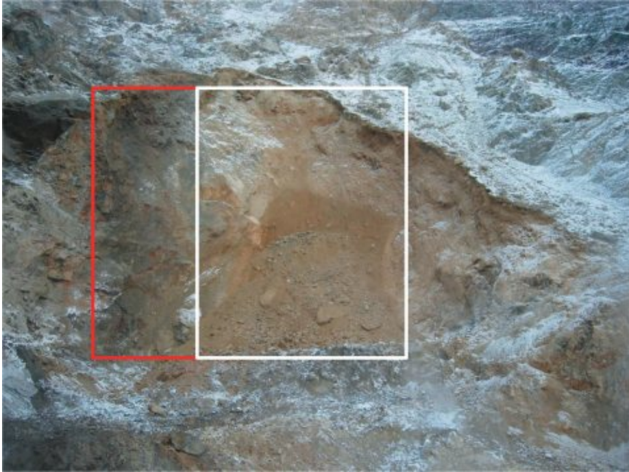
Рис. 3.5.17. Положение горных работ на участке перед отработкой запасов камеры 30-013 (январь 2012 г.). Красным прямоугольником показан контур камеры 30-013, белым – зона в которой была произведена отгрузка горной массы из зоны обрушения камеры 34-013
