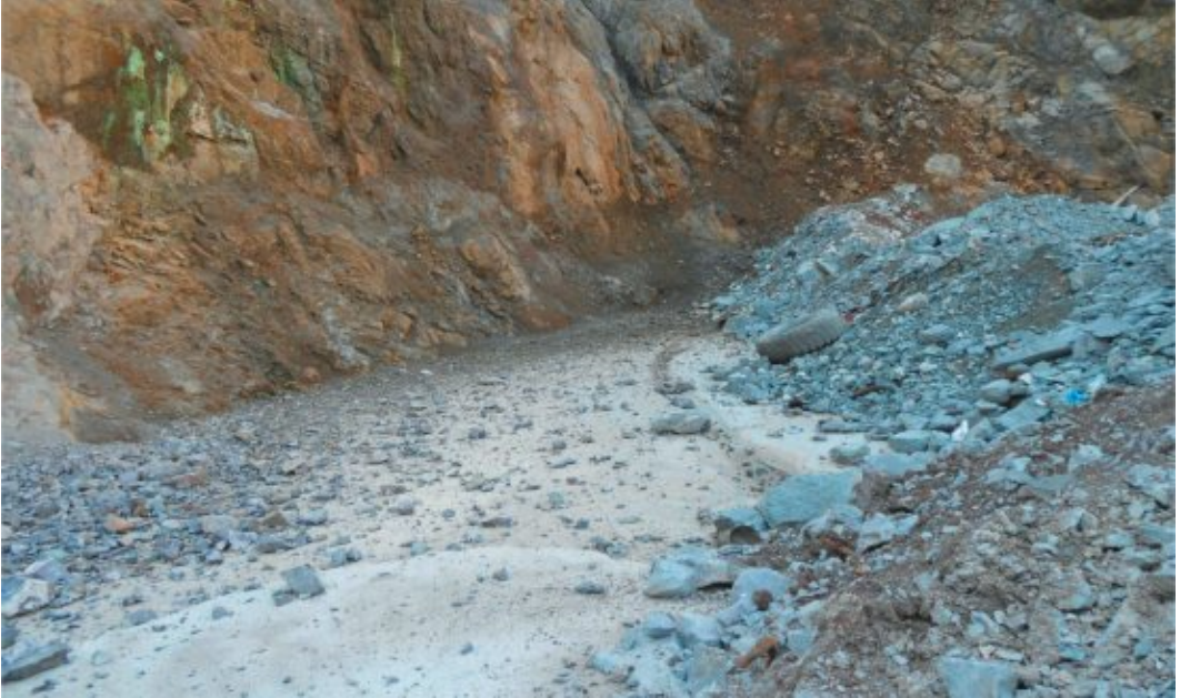
Рис. 3.3.15. Начальная стадия возведения комбинированного искусственного целика вдоль борта карьера (первый этап отсыпки скальной пригрузки на кровле отработанной камеры К1ПЦС4-240)
