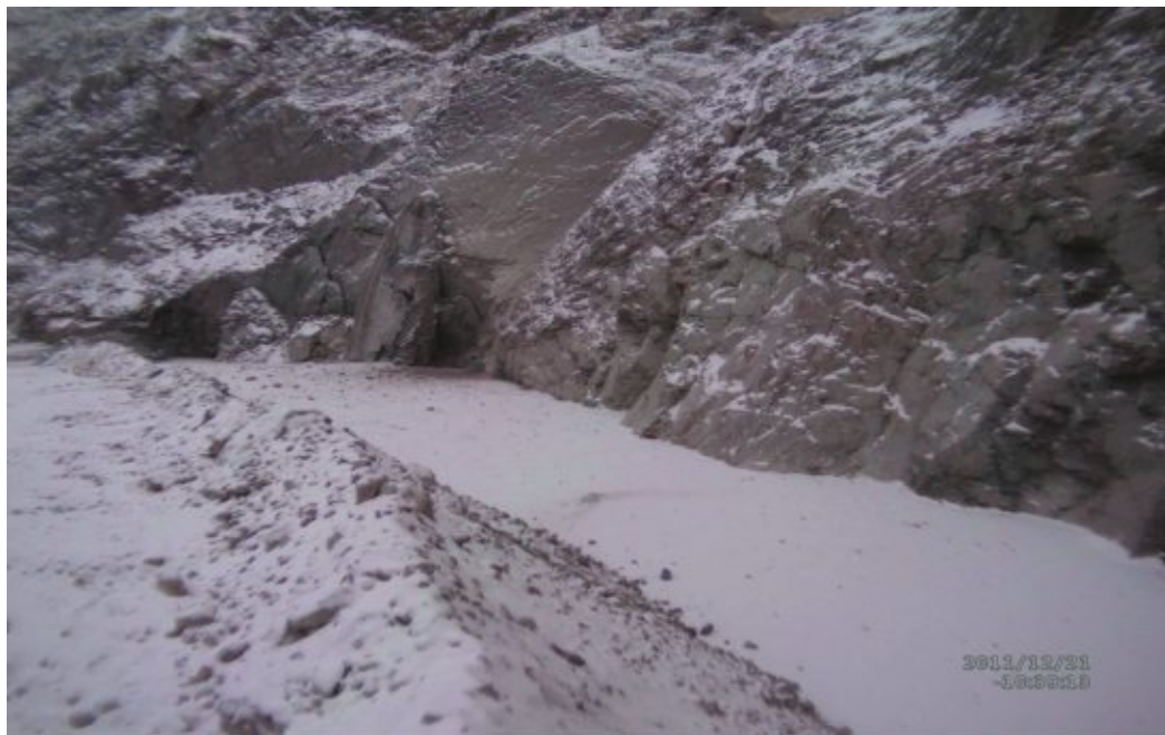
Рис. 3.3.17. Возведение комбинированного искусственного целика вдоль борта карьера (твердеющая закладка + скальная пригрузка)
