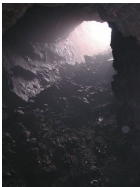
Рис. 3.6.4. Состояние очистного пространства камеры 30-17/20 со стороны подводящих подземных выработок (при подходе с северного фланга камеры)
