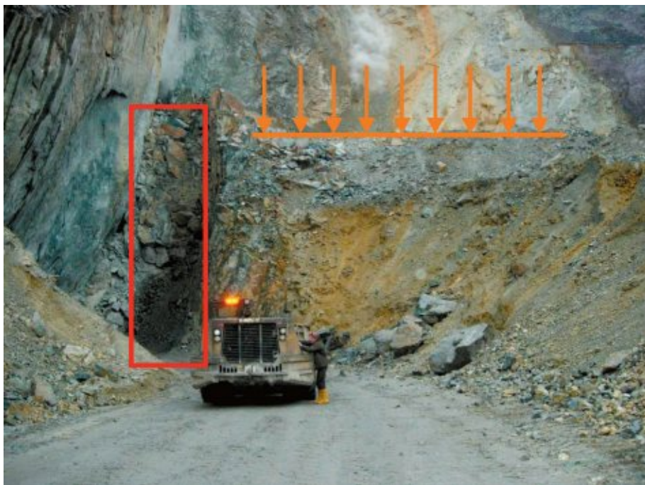
Рис. 3.6.3. Выработанное пространство камеры 30-17/20, заполненное породами, после окончания выемки прикарьерной части рудного тела № 20 (вид со стороны карьера)
