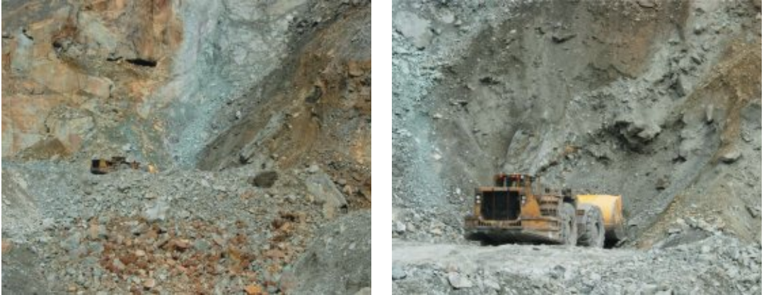
Рис. 3.5.24 и 3.5.25. Отгрузка руды из камеры 30-012 с помощью ПДМ Caterpillar R2900, оборудованной системой дистанционного управления
