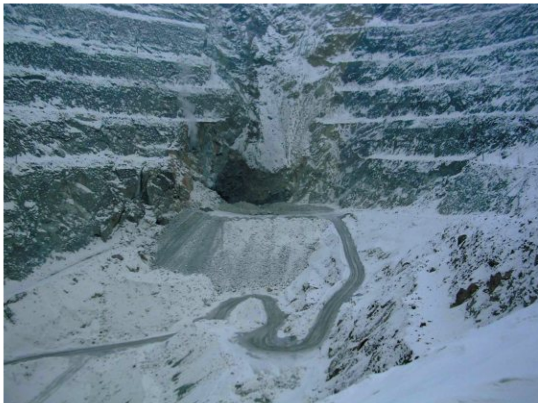
Рис. 3.4.27. Положение горных работ после окончания пригрузки борта в отметках горизонтов 300–340 метров
