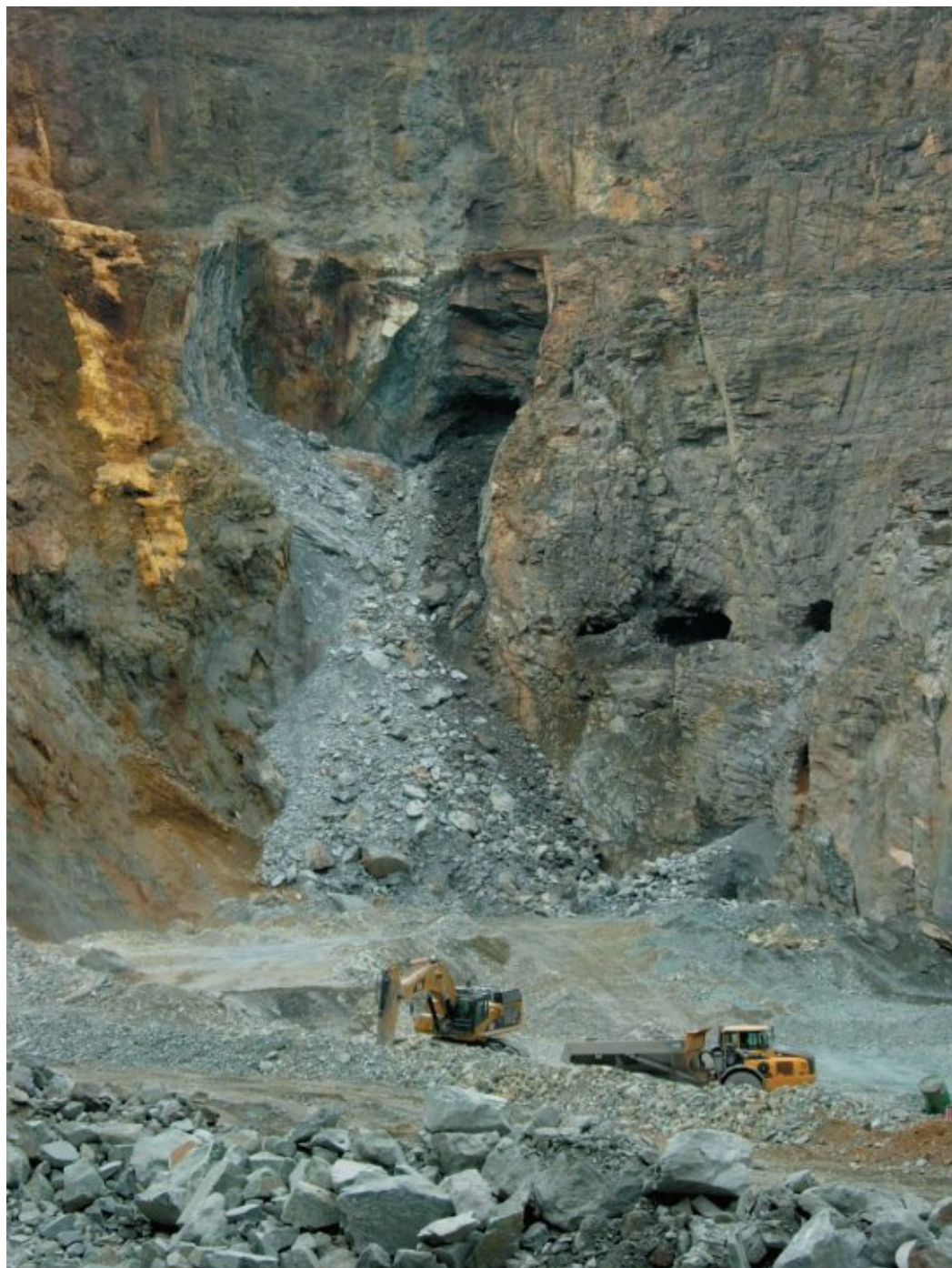
Рис. 3.7.20. Положение горных работ на Южной выклинке Учалинского карьера через месяц после отбойки последнего веера в камере 30-3ю (запасы выше горизонта 300 метров)
